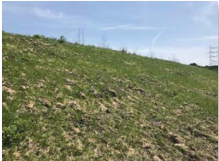
Vegetación significativa lograda dentro de un mes de instalación: abril de 2018.
