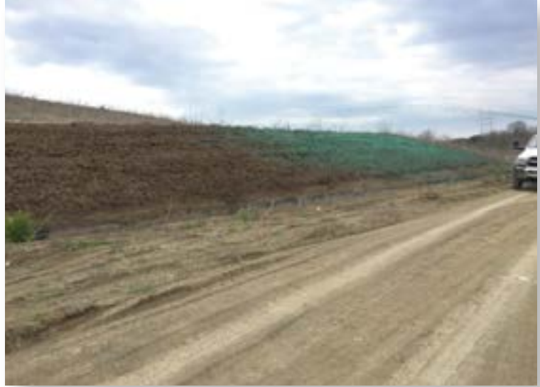
Instalación de Biotic Earth de marzo de 2018, cubierta con una FGM en una hora.
